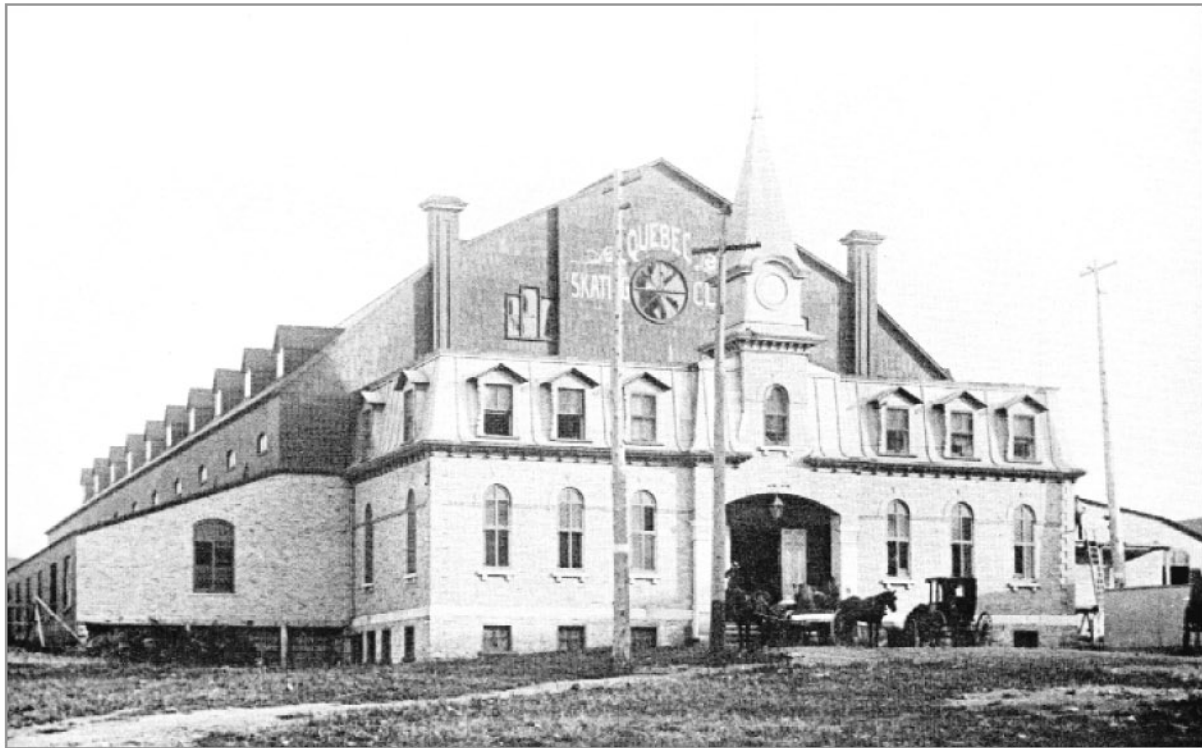
L'édifice du Skating Rink avant qu'il ne soit complètement détruit par l'incendie.
