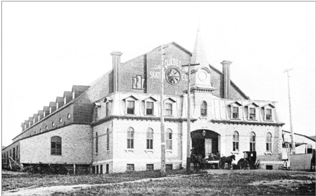
L'édifice du Skating Rink avant qu'il ne soit complètement détruit par l'incendie.
